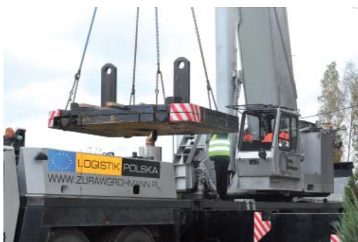
фото: оснастка крана
